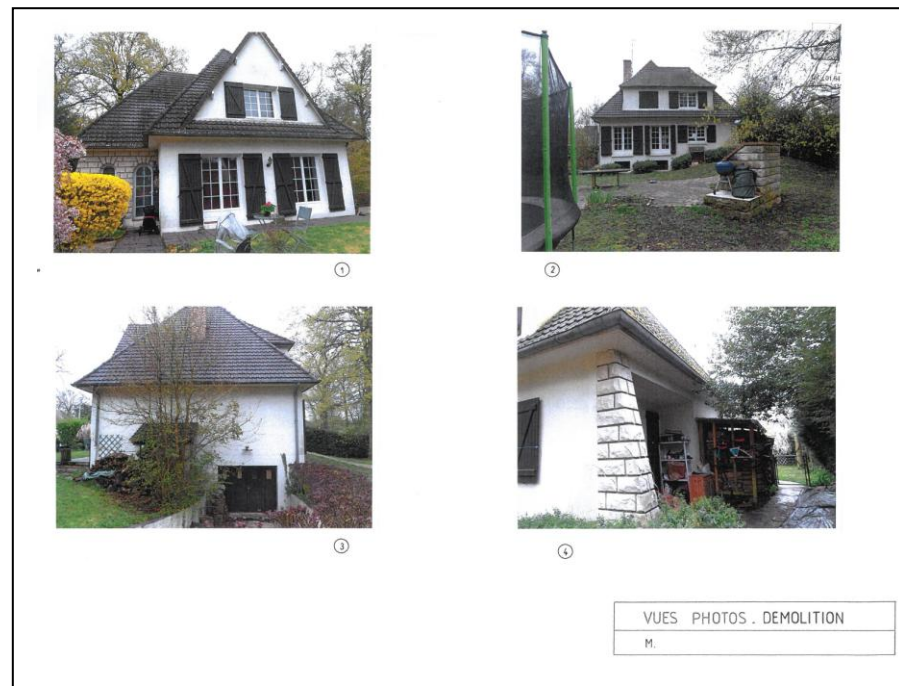
A2 – PHOTOS DU BATIMENT A DEMOLIR
